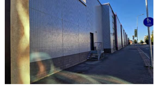
Kuva 16. Kauppakeskuksen julkisivu Lapinkävijäntielle Kukkolan talon päässä
