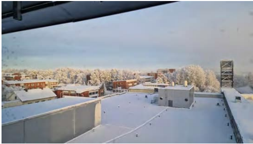
Kuva 17. Kauppakeskuksen vesikatto kuvattuna toimistotalosta.
